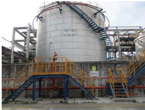
รูปที่ 3.2-57 ถังคอนกรีตล้อมรอบถังเก็บกัก
