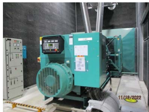
รูปที่ 3.2-9 ระบบจ่ายไฟฟ้าสำรอง
