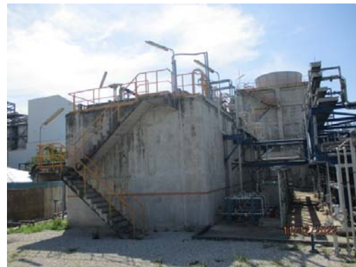
รูปที่ 3.2-23 ถังเติมอากาศ (AS System (แบบ SBR))
