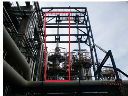
รูปที่ 3.2-3 ระบบ Acetone Scrubber (D-1904)
